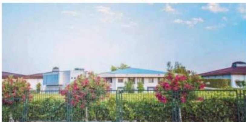
Instalaciones de Bodegas Valdemar en Oyón. / NR
